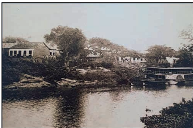
PORTO de Monção no rio Pindaré por volta de 1930. Fonte: Ronilson Sousa.
